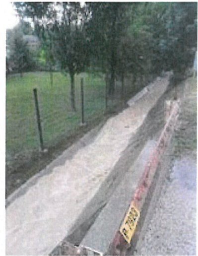
Korábban kiburkolt árok
